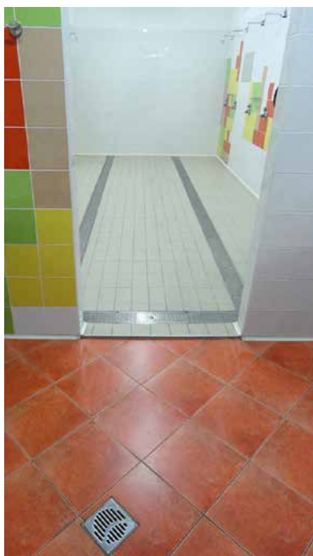
Vse v nivoju tlaka, točkovni požiralnik v predprostoru in linijski požiralnik v področju tušev.
