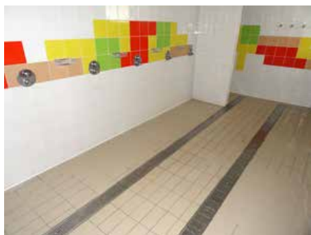
Dve liniji talnih požiralnikov ACO Modular zagotavljata učinkovito odvodnjavanje skupnih tušev.
