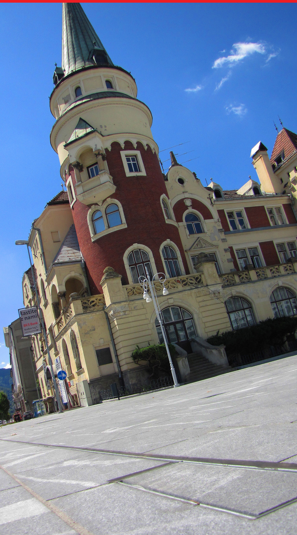
Fontana pred Celjskim domom. Ker je teren nekoliko v naklonu, je na spodnji strani kamor se steka več vode zaradi večje varnosti vgrajena posebna izvedba kanalete z dvema regama. Na vogalu je revizijski element.
