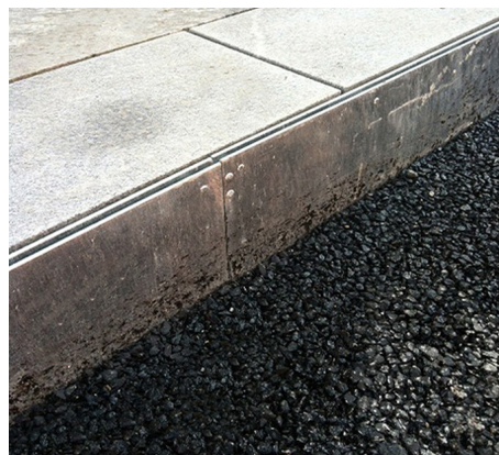
Brickslot vgradnja. Na eni strani rege so že položene tonalitne plošče, na drugi strani pa šele drenažni asfaltni sloj na katerega pride položen zaključni tlak. Zaradi specifičnih zahtev projekta smo izdelali posebno rego višine 20 cm, svetla širina rege je 13 mm. Pokrov nastavka z rego je tudi perforiran za odvodnjavanje pronicujočih vod.
