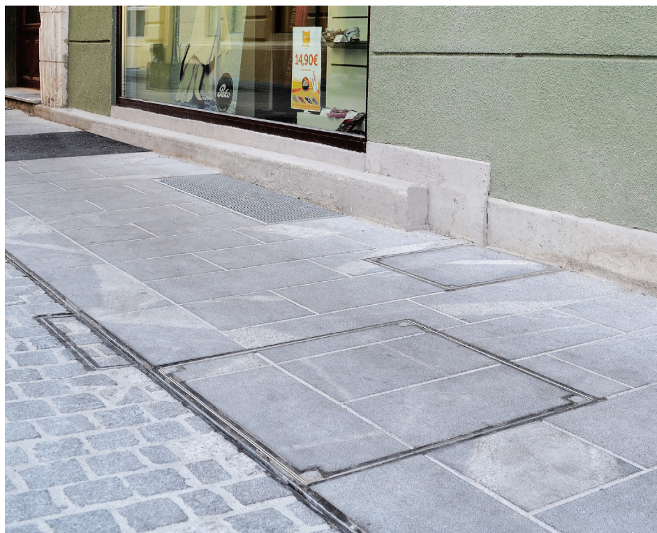
ACO Toptek pokrovi za revizijske jaške se odlično zlivajo z okolico. Kanaleta z rego tudi kot arhitektonski element za razmejitve med tonalitnimi ploščami in granitnimi kockami. V ozadju ACO Markant mreža svetlobnega jaška.
