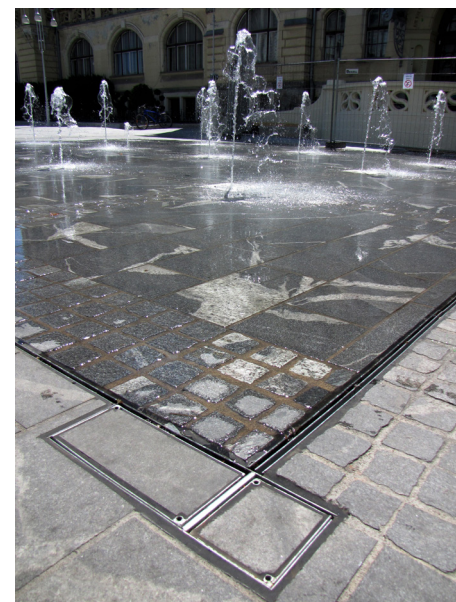
Fontana pred Celjskim domom. Ker je teren nekoliko v naklonu, je na spodnji strani kamor se steka več vode zaradi večje varnosti vgrajena posebna izvedba kanalete z dvema regama. Na vogalu je revizijski element.
