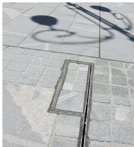
ACO Brickslot revizijski element za nemoteno vzdrževanje in čiščenje notranjosti kanalete.
