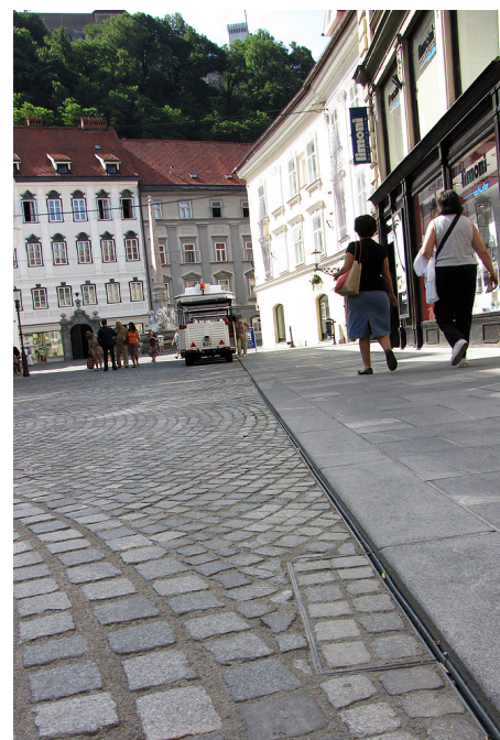
Kanaleta z režo in revizijski element na Stritarjevi ulici
