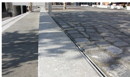
Kanaleta z režo SR med na novo urejeno brežino in ulico
