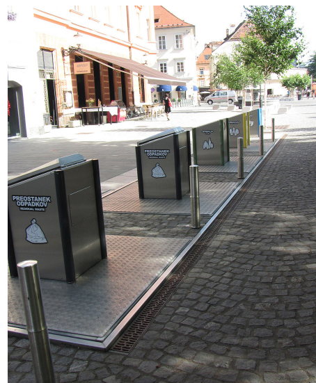
Linijski požiralnik ACO Drain Multiline preprečuje vdor meteornih vod v podzemni smetnjak
