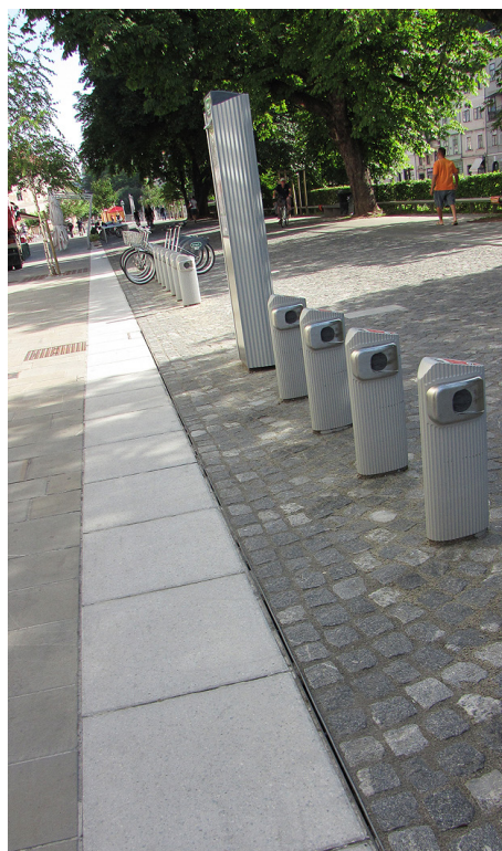
Postajališče za Bicikelj, odvodnjavanje kanaleta z režo
