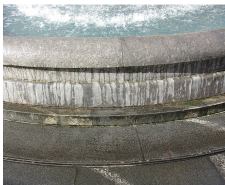
Neposredna okolica fontane je obdana s krožno - po individualnih zahtevah izdelano - kanaletu z režo ACO Drain Multiline SR.
