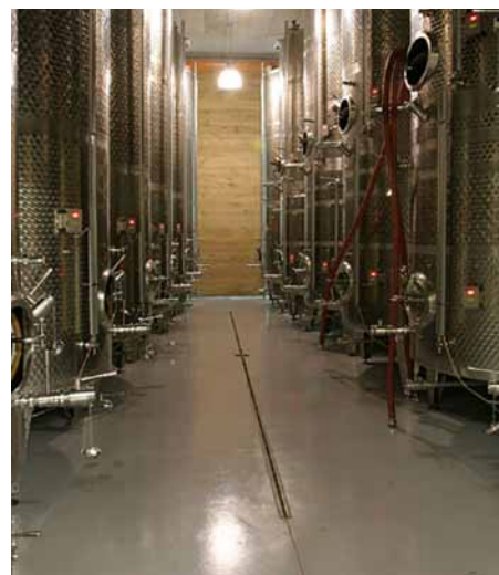
Posebna-protizdrsna-oblika pokrivne rešetke na kanaleti zagotavlja dodatno varnost zaposlenih.
