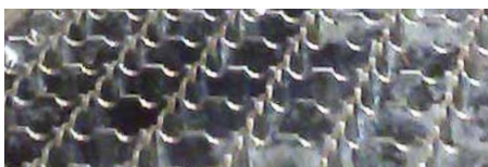
Posebna-protizdrsna-oblika pokrivne rešetke na kanaleti zagotavlja dodatno varnost zaposlenih.
