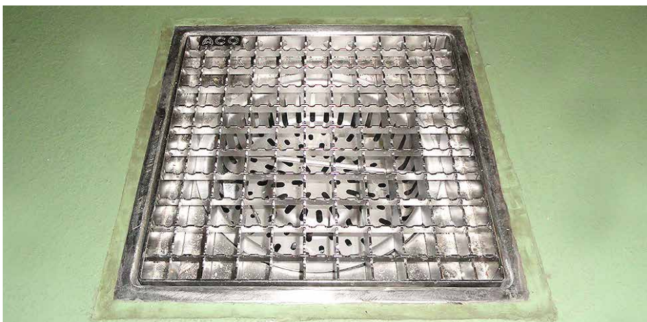
ACO talni požiralnik s vstavljenim sitom za grobe nečistoče in protizdrsko pokrivno rešetko, vgrajen v betonska tla s protizdrsnim epoksi premazom.
