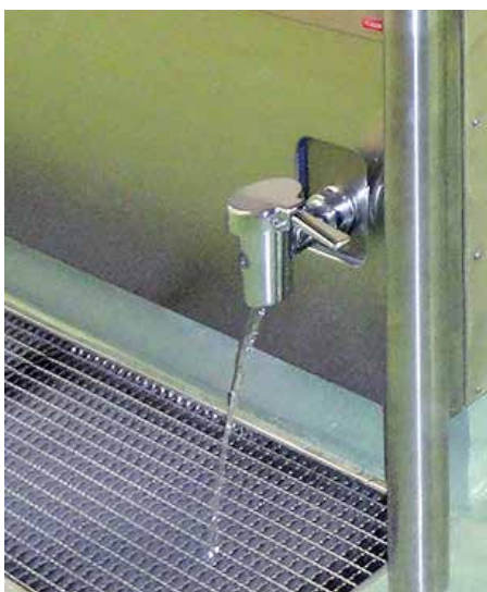
ACO talni požiralnik s vstavljenim sitom za grobe nečistoče in protizdrsko pokrivno rešetko, vgrajen v betonska tla s protizdrsnim epoksi premazom.
