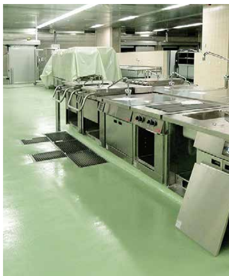
ACO talni požiralnik s vstavljenim sitom za grobe nečistoče in protizdrsko pokrivno rešetko, vgrajen v betonska tla s protizdrsnim epoksi premazom.
