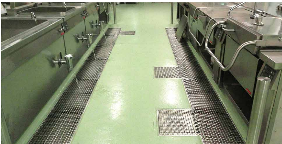
ACO talne kanalete iz nerjavečega jekla (levo in desno) se proizvajajo v različnih dimenzijah, vrstah robov (glede na zaključni tlak) in volumnih (do 100 litrov).
