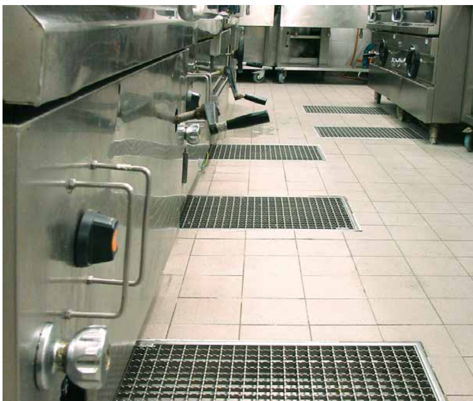
Primer odvodnjavanja v medetažni konstrukciji s požiralnikom s tlačno prirobnico.
