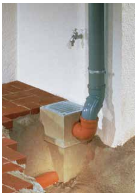
Dvorišni požiralnik z nastavnim elementom za priklop strešnih vod.
