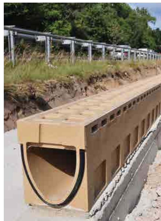
Vgradnja ACO Monoblock kanalete za odvodnjavanje pronicujočih vod drenažnega asfalta.
