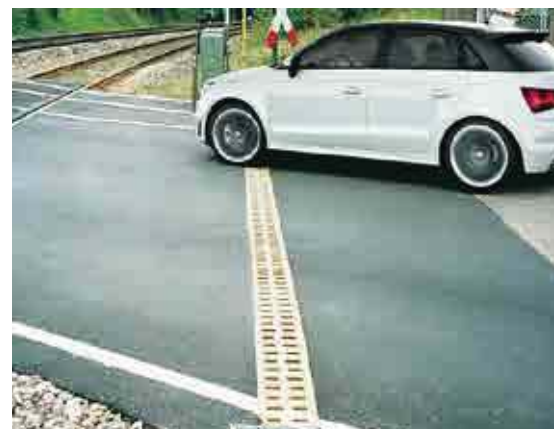
Prečno odvodnjavanje vozišč.
