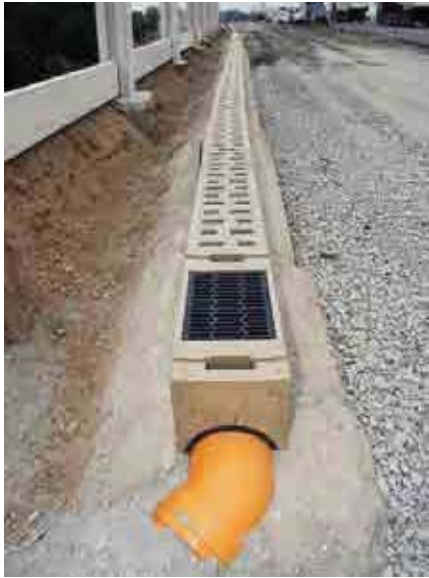
ACO Monoblock RD 200 V z revizijskim elementom in čelno steno z iztokom.
