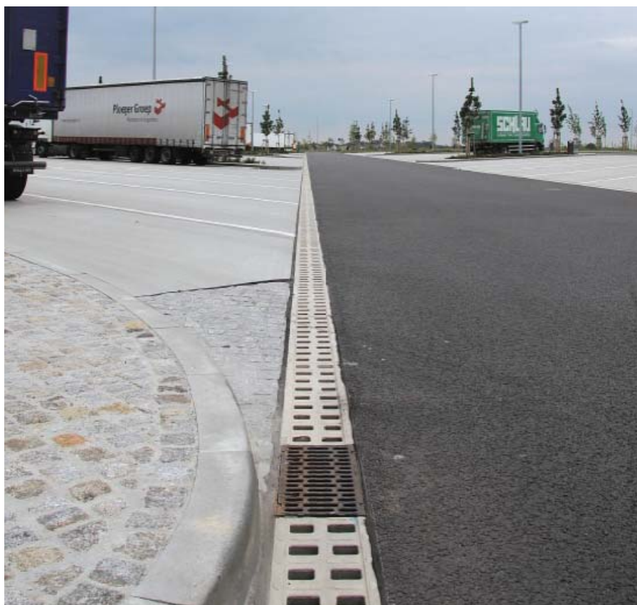
Vgradnja ACO Monoblock kanalete za odvodnjavanje pronicujočih vod drenažnega asfalta.
