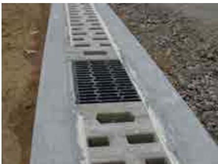
Pristop kanalu za čiščenje in vzdrževanje je mogoč preko revizijskega elementa ali zbiralnika, ki sta opremljena s snemljivo litoželezno pokrovno rešetko.
