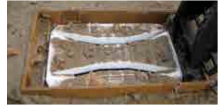
Opaž preprečuje vnos peska in ostale umazanije v požiralnik oz. kanalizijsko cev med gradbenimi deli.
