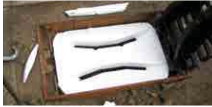
Opaž pokriva odprtino in se po zaključku del odstrani.
