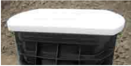
Opaž iz polistirena kot pripomoček za lažjo izdelavo 2 cm visokega betonskega ležišča za okvir rešetke.
