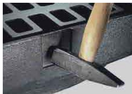
Predoblikovanje za odvodnjavanje v času vgradnje
