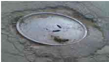
Poškodovano cestišče zaradi prenizke višine okvirja.
