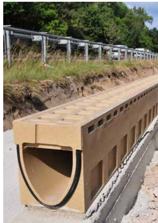
Vgradnja ACO Monoblock kanalet za odvodnjavanje pronicajočih vod drenažnega asfalta.
