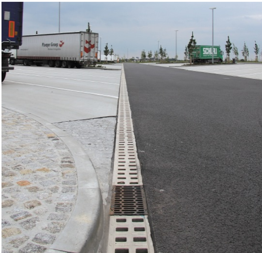
Vgradnja ACO Monoblock kanalet za odvodnjavanje pronicajočih vod drenažnega asfalta.
