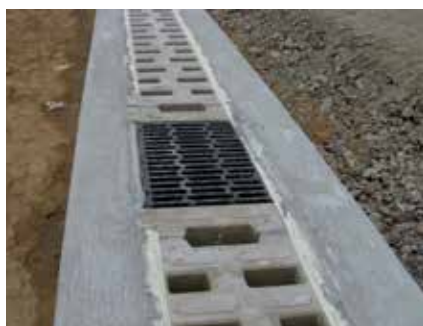
Pristop kanalu za čiščenje in vzdrževanje je mogoč preko revizijskega elementa ali zbiralnika, ki sta opremljena s snemljivo litoželezno pokrovno rešetko.
