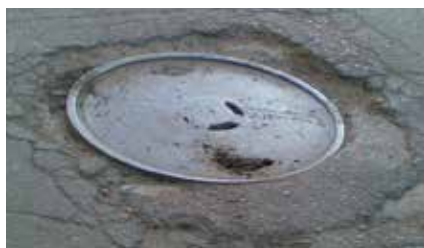
Poškodovano cestišče zaradi prenizke višine okvirja.
