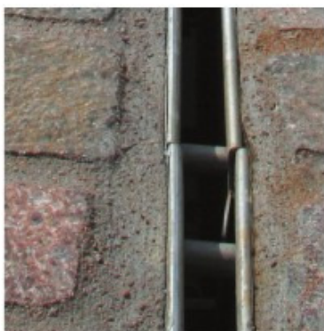
Spoj dveh nastavkov brez adapterja
