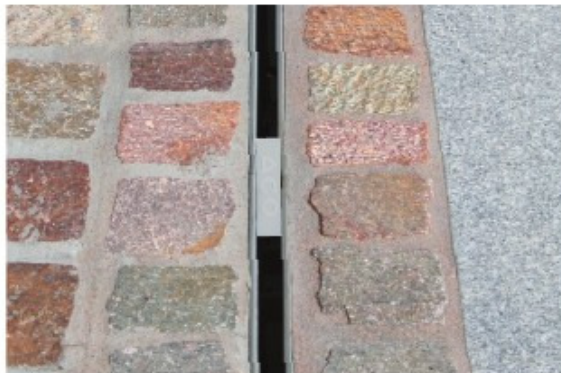
Spoj dveh nastavkov z adapterjem
