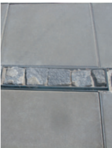
Primer vgradnje revizijskega elementa.
