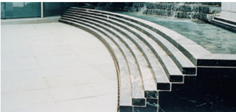
Letališče Stuttgart, V100 S, z asimetrično rego, vgrajeno v loku ob stopnišču.
