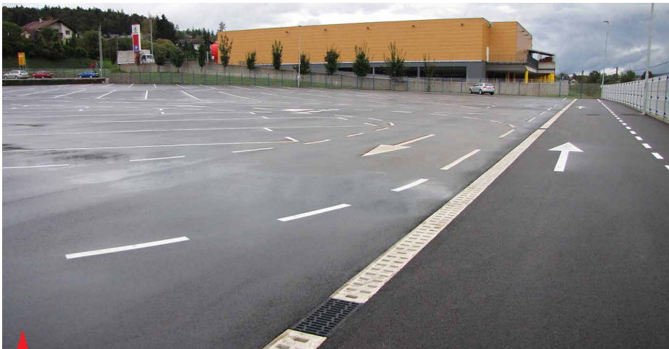
Revizijski element omogoča dostop do iztočne cevi in v notranjost kanalete
