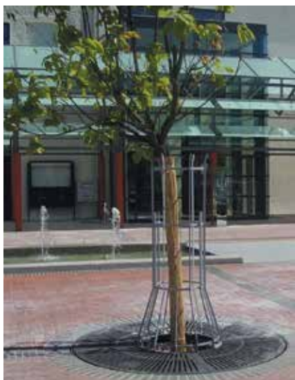
Standard drevesne rešetke varno ščitijo koreninski sistem pred poškodbami.
