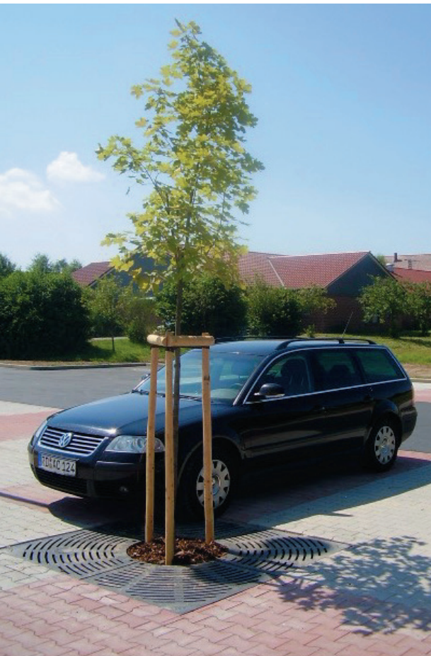
Dem Nutzungsdruck widerstehen: Baumschutzroste schützen den Wurzelbereich in Stellplatzbereichen und bieten zusätzlichen Parkraum
