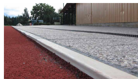
Elastičen robnik za razmejevanje različnih športnih površin. Gumijasta obroba zagotavlja varnost udeležencev.
