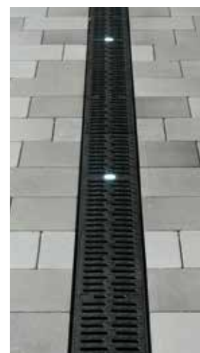
Odvodnjavanje in ACO Eyeleds, razdalja med LED 100 cm.
