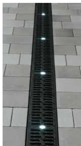
Odvodnjavanje in ACO Eyeleds, razdalja med LED 50 cm.
