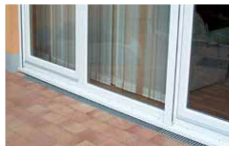
Zaprta kanaleta (Euroline, Hexaline) na zaprti talni konstrukciji (keramika na betonskem estrihu) za odvodnjavanje panoramskega okna.
