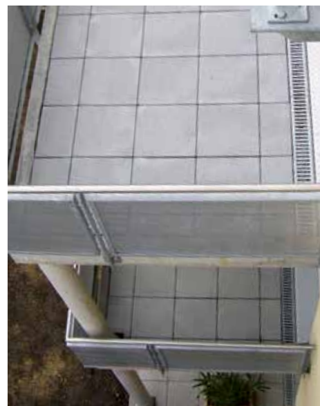
Odrpna kanaleta (Highline) za odvodnjavanje balkona z odprto talno konstrukcijo (betonske plošče na nasutju iz prodca).
