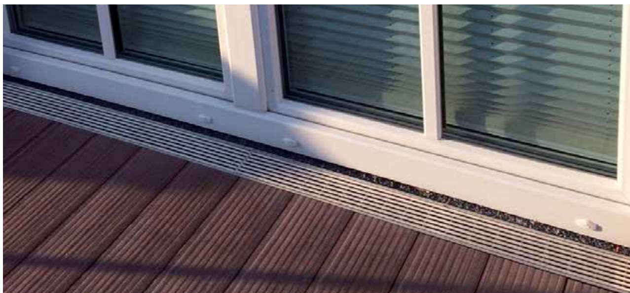
Odrpna kanaleta (Highline) na odprti talni konstrukciji (lesene deske) za odvodnjavanje panoramskega okna ( hkrati preprečuje škropljenje vode po steklu ob deževju).
