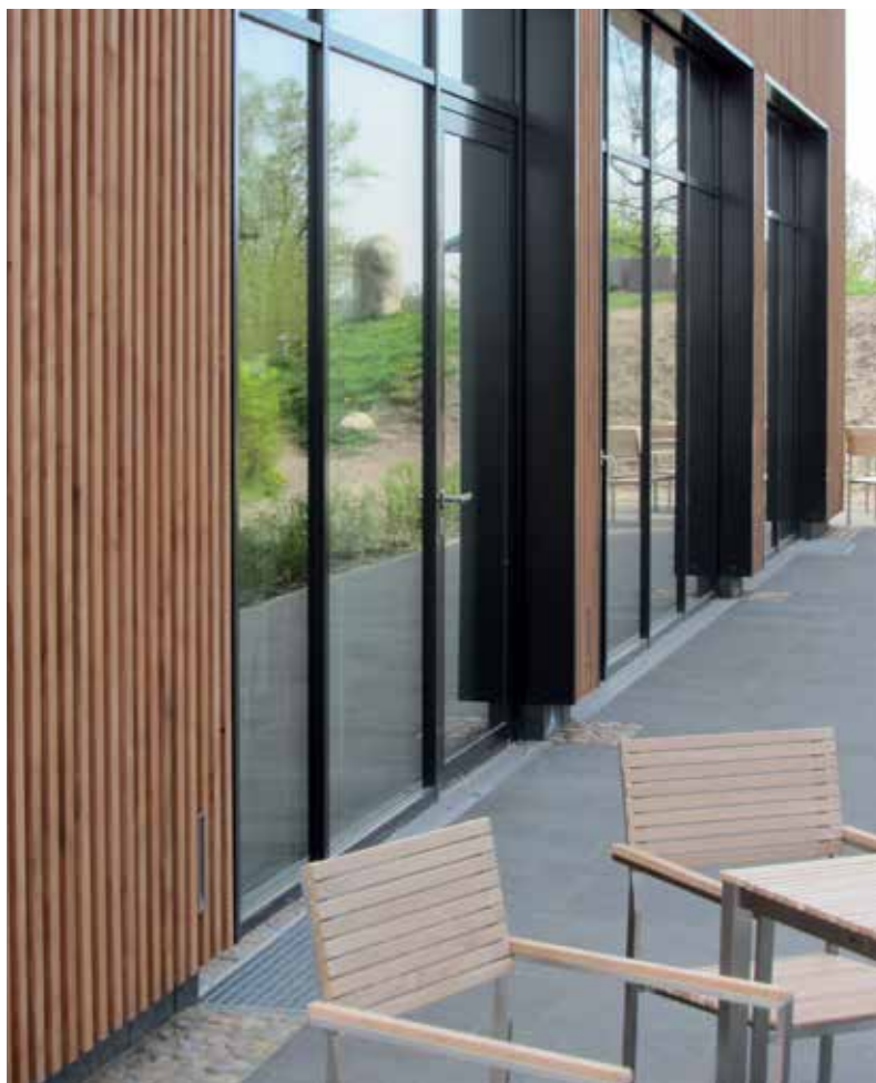
Zaprta kanaleta (Euroline, Hexaline) na zaprtih talnih konstrukcijah (betonski estrih s keramiko, kamnom...).
