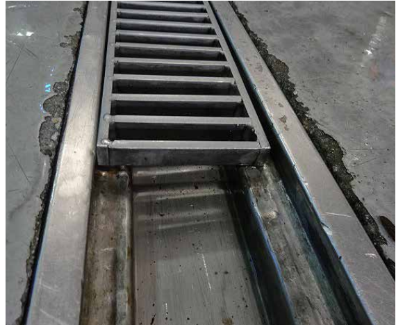
Slika 3 - Zatekanje v stik med tlakom in sistemom za odvajanje tekočin
