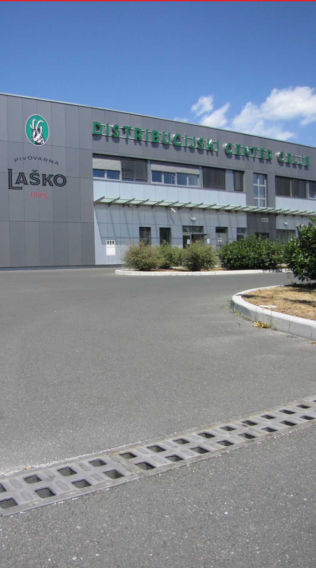
Monoblock RD200V z zbiralnikom s snemljivo litoželezno pokrivno rešetko preko katere pristopamo v notranjost kanalete.
