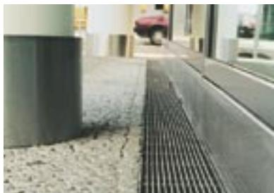
Sistem linijskih požiralnikov iz nerjavečega jekla različnih širin in pokrivnih rešetk, omogočajo individualno oblikovanje in zanesljivo odvodnjavanje meteornih vod iz utrjenih površin.
