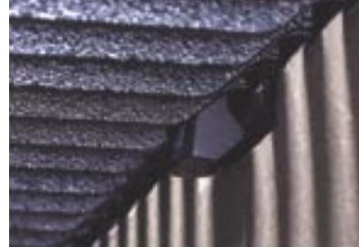
Brezvijačen sistem aretiranja pokravnih rešetk Drainlock®, preprečuje vzdolžno premikanje rešetk in omogoča enostavno in hitro montažo ter demontažo rešetk.
