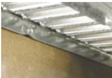
Pokrivne rešetke so brezvijačno pritrjene na telo kanalete.
