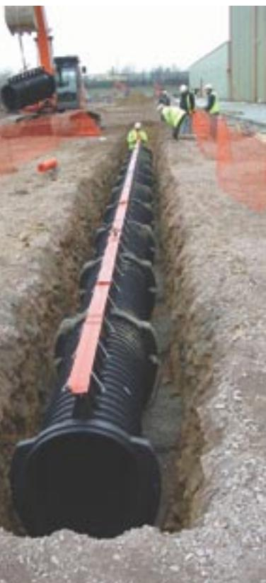
*ACO Qmax® je razvit z namenom odvodnjavanja ekstremno velikih količin meteornih vod iz velikih prispevnih površin. Lahko se vgradi tudi v površine na katerih se pričakujejo ekstremne obremenitve, to je vse do F 900 kN po SIST EN 1433.*
