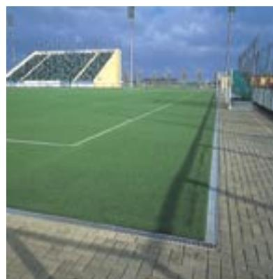
ACO SPORT® sistem linijskih požiralnikov za odvodnjavanje športnih terenov opremljenih z umetno travo.
