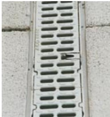
Primer po posebni metodi v sivo barvo pocinkane litoželezne rešetke in zaščitnega okvirja za vizualno skladnost z betonskim zaključnim slojem.
