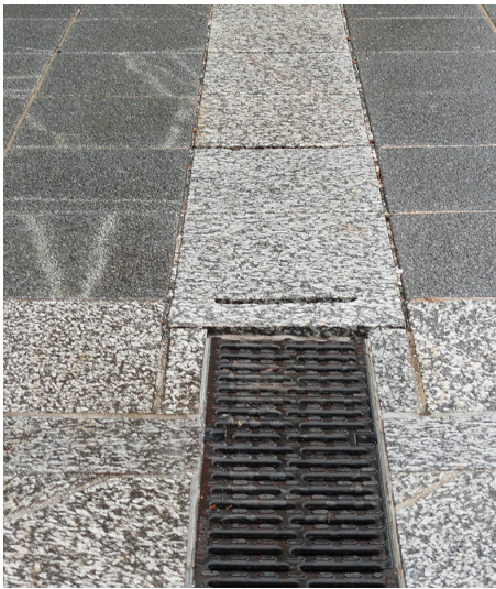
Izvedba detajla: prehod linijskega požiralnika Multiline V150 z litoželezno rešetko v linijski požiralnik Multiline V200 z vstavljenim kamnitim tlakom
