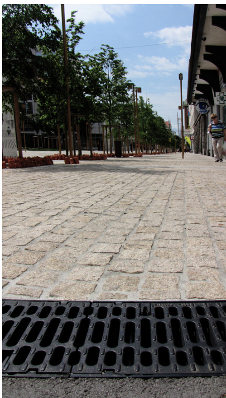
Linjski požiralnik za odvodnjavanje meteornih vod ACO Drain SK
