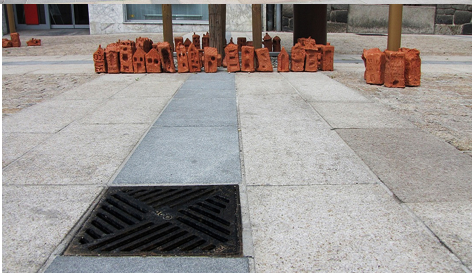
Točkovni požiralnik za odvodnjavanje meteornih vod ACO Drain
