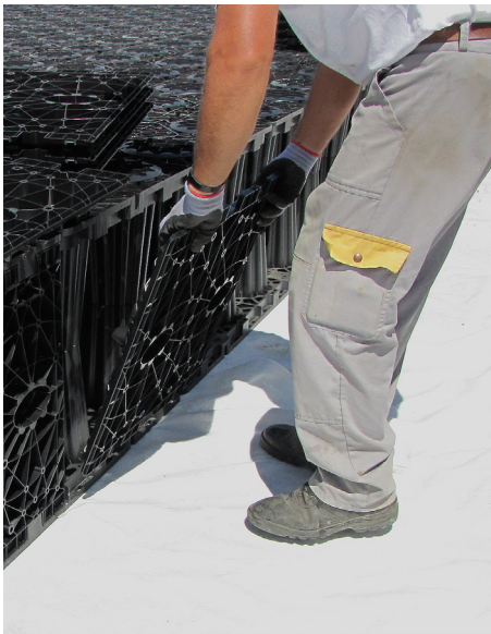
Zapiranje bočnih strani ponikalnice je kot celoten potek sestavljanja ponikalnega polja enostaven in hiter.
