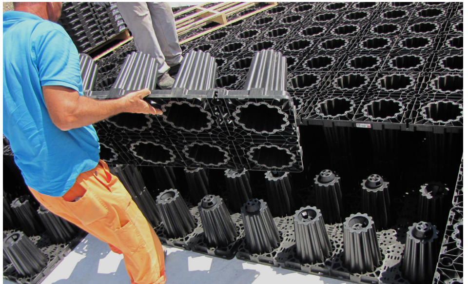
Z dimenzijo osnovnega elementa 120 x 60 x 30 cm in težo 10 kg, zagotovljeno enostavno rokovanje in hitra montaža.
