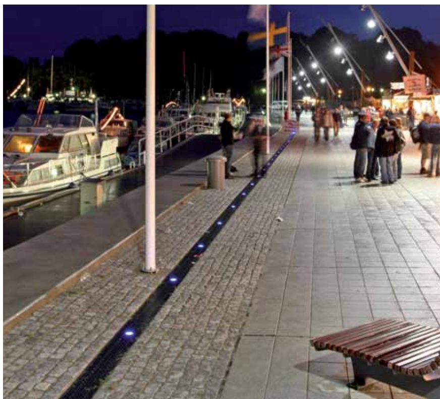
ACO Lightpoint kot kombinacija osvetlitve in odvodnjavanja; pristanišče Obereider v Rendsburgu, Nemčija.
