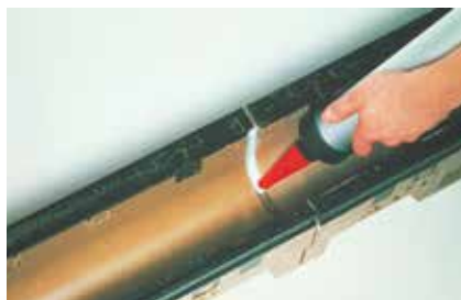
Varnostni utor (SF) za zatesnitev spojev med posameznimi elementi
