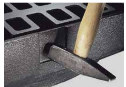
Predoblikovanje za odvodnjavanje med gradnjo
