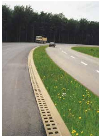
Vzdolžno odvodnjavanje vozišč.
