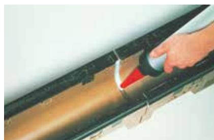
Zaščitni okvir kanalete je izdelan tako, da je mogoče z izvedbo diletacije naknadno zatesniti tudi stik med robom kanalete in priključno prispevno površino. Oboje je mogoče zatesniti z ACO trajnoelastično tesnilno maso.
