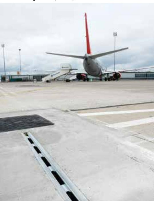
ACO Qmax je najzmogljivejši sistem za linjsko odvodnjavanje in zadrževanje padavinskih vod, razvit z namenom, da bi se zadovoljile potrebe po čim bolj učinkovitem in ekonomičnem odvodnjavanju velikih in največjih prispevnih površin.
