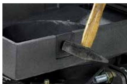
Bočna predoblikovanja v okvirju za začasno odvodnjavanje tekom gradnje.
