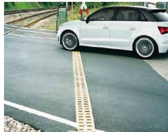
Prečno odvodnjavanje vozišč.
