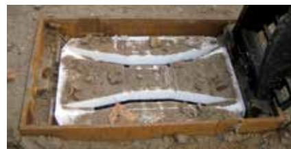
Opaž preprečuje vnos peska in ostale umazanije v požiralnik oz. kanalizacijsko cev med gradbenimi deli.
