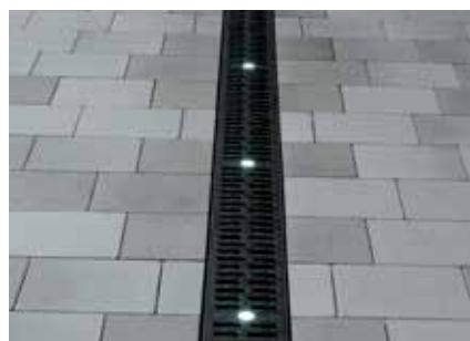
Odvodnjavanje in ACO Eyeleds,
