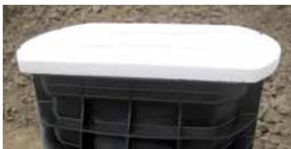
Opaž iz polistirena kot pripomoček za lažjo izdelavo 2 cm visokega betonskega ležišča za okvir rešetke.
