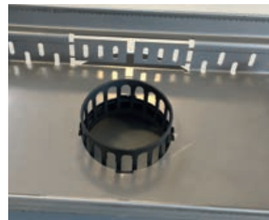
Einsetzen des Einsteckstutzens
