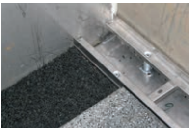
Rinnensystem lose verlegt
