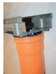
Anschließen des KG-Rohres DN 100
