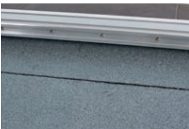
Anschluss einer bituminösen Abdichtung mit Keilausbildung
