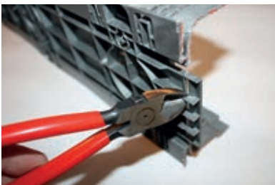
Kürzen des Rinnenendes im Bodenbereich
