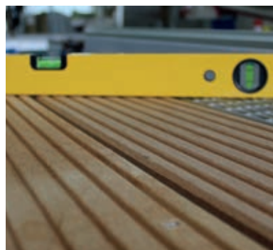
Kontrolle der Einbauhöhe
