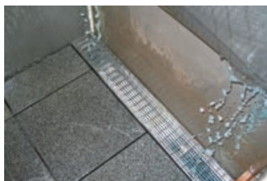
Beregnung der Fassadenrinne im Einbau
