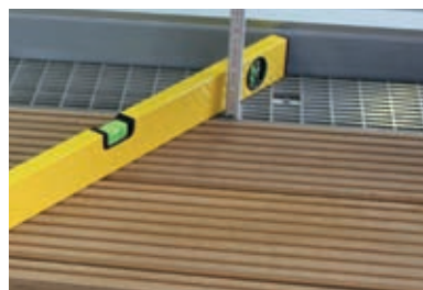
Einpassen der Holzterrassenrinne
