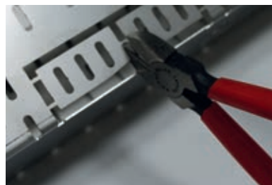
Öffnen des Stichkanalanschlusses
