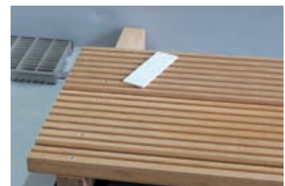
Rinnenkörper nach Notwendigkeit bau-seits unterfüttern
