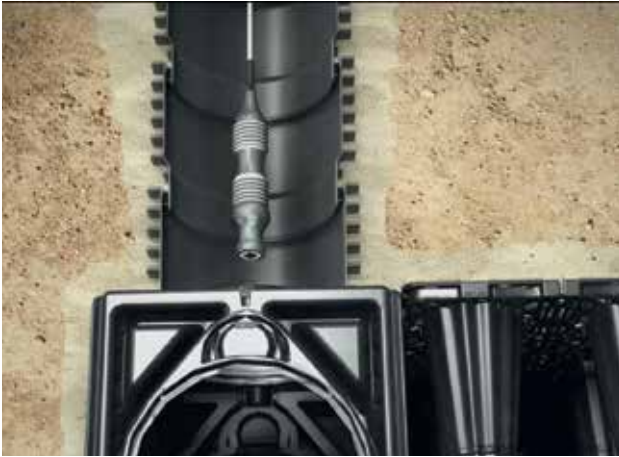
Spuščanje kamere skozi vertikalne pristopne točke za pregled in izpiranje
