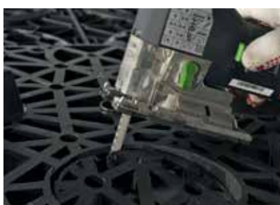
Izdelava odprtine za cevni priključek v čelni steni
