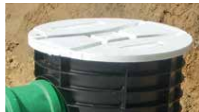
Zaščitni opaž iz stiroporja preprečuje vnos gradbenega materiala v notranjost in mora ostati na elementu cel čas vgradnje.
