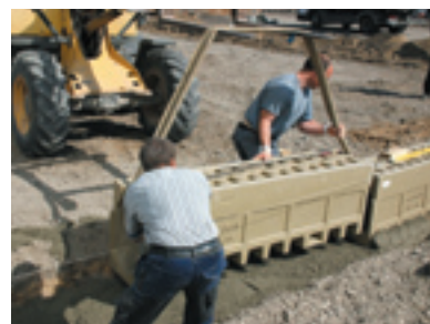
Polaganje kanalet ACO DRAIN® Monoblock RD300
