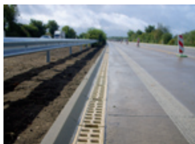
ACO DRAIN® Monoblock RD200 V, vzdolžno odvodnjavanje avtoceste
