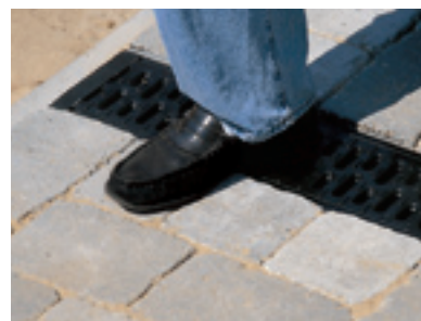
Rešetko na revizijski element pritrdimo s pritiskom nanjo
