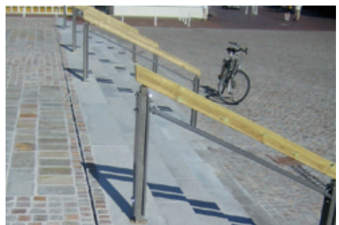
ACO DRAIN SR kanalete z režo ob stopnišču.
