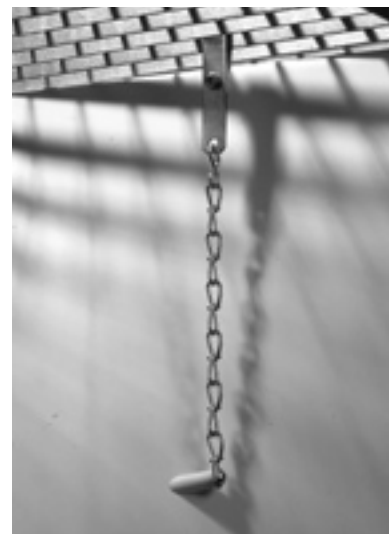
Protivlomno varovalo (pričvrščeno v pokrivno mrežo in telo svetlobnega jaška)
