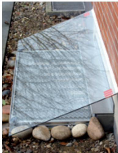
Zaščita svetlobnega jaška iz varnostnega stekla
