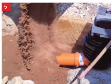
Zasipamo po SIST EN 1610 z ustreznim zasipnim materialom.
