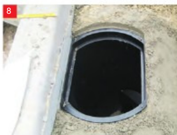
Betonska odprtina pripravljena za vstavev vtočne rešetke.
