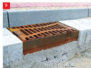
Vtočna rešetka z betonsko podlago. Ojačitve iz umetne mase moramo popolnoma obbetonirati.
