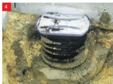
Spodnji del postavimo na temelj iz betona C 12/15 ter ga obbetoniramo do prve ojačitve.
