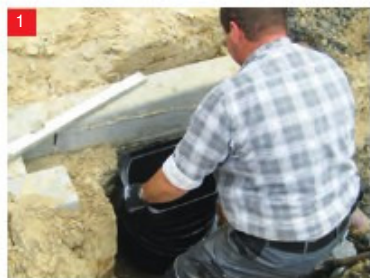
Enostavno rokovanje na gradbišču ter pri sestavljanju posameznih sestavnih delov.
