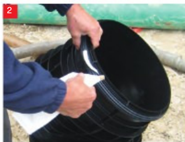
Priprava zgornjega dela z nanosom maziva pred sestavljanjem.
