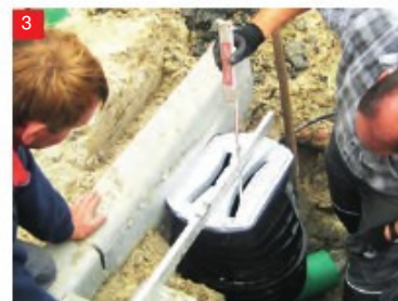
Optimalna nastavev požiralnika zahvaljujoč vrtljivosti, teleskopske višinske nastavljalnosti ter prilagoditve na poljuben prečni oz. vzdolžni nagib.
