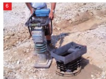
Utrdimo z lahkim strojem za zbijanje do oznake „Unterkante Beton“ na zgornjem elementu iz umetne mase.
