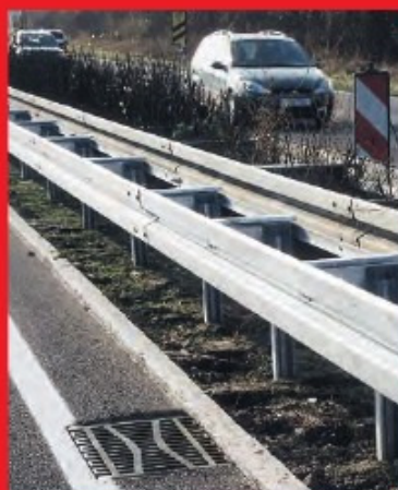
ACO Combipoint PP kot požiralnik na avtocesti
