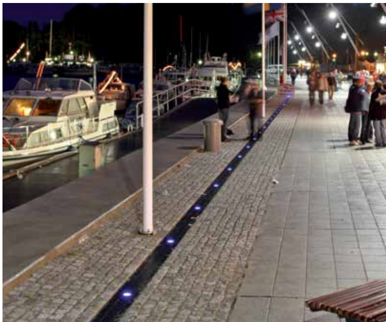
ACO Lightpoint kot kombinacija osvetlitve in odvodnjavanja; пристанище Obereider v Rendsburgu, Nemčija.
