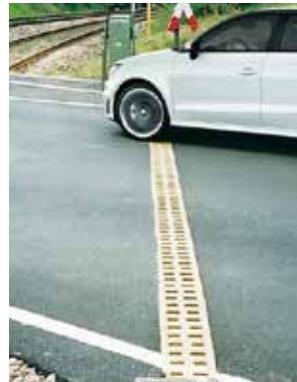
Prečno odvodnjavanje vozišč.
