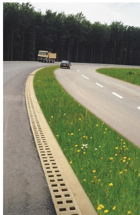
Vzdolžno odvodnjavanje vozišč.
