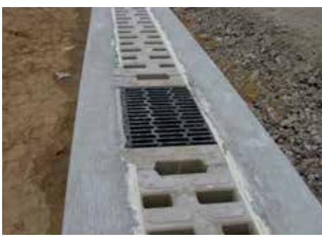
Pristop kanalu za čiščenje in vzdrževanje je mogoč preko revizijskega elementa ali zbiralnika, ki sta opremljena s snemljivo litoželezno pokrivno rešetko.
