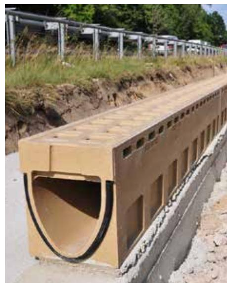
Vgradnja ACO Monoblock kanalet za odvodnjavanje pronicajočih vod drenažnega asfalta.
