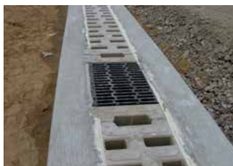
Pristop kanalu za čiščenje in vzdrževanje je mogoč preko revizijskega elementa ali zbiralnika, ki sta opremljena s snemljivo litoželezno pokrivno rešetko.
