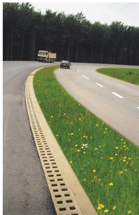
Vzdolžno odvodnjavanje vozišč.
