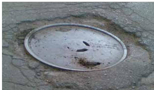
Poškodovano cestišče zaradi prenizke višine okvirja.
