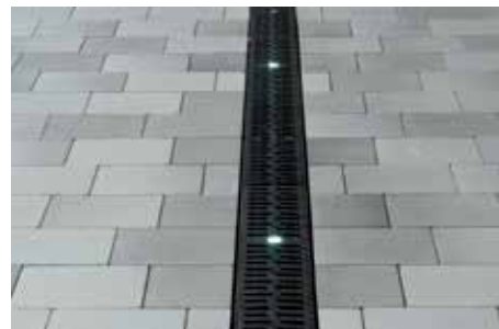
Odvodnjavanje in ACO Eyeleds, razdalja med LED 100 cm
