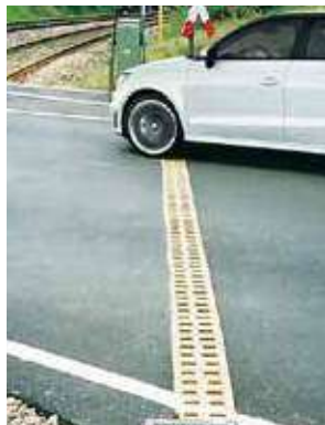
Prečno odvodnjavanje vozišč.
