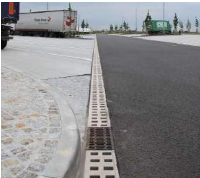
Vgradnja ACO Monoblock kanalet za odvodnjavanje pronicajočih vod drenažnega asfalta.
