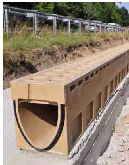
Vgradnja ACO Monoblock kanalet za odvodnjavanje pronicajočih vod drenažnega asfalta.
