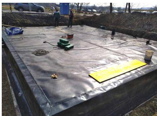
Natančno krojenje geomembrane po obodu zadrževalnika s premičljjenimi preklopi in sistemu avtomatskega ter ekstruzijskega varjenja za 100% vodotesnost.
