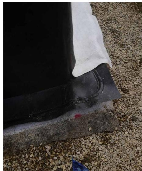
Detajl obodnega zvara horizontalne geomembrane položene na tla in bočne geomembrane zadrževalnika.
