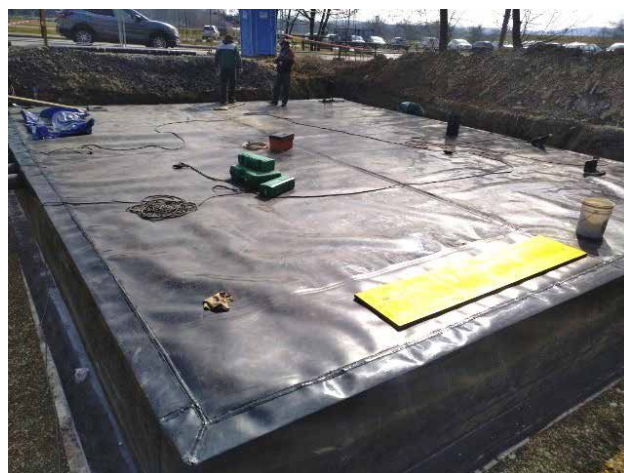
Natančno krojenje geomembrane po obodu zadrževalnika s premišljenimi preklopi in sistemu avtomatskega ter ekstruzijskega varjenja za 100% vodotesnost.
