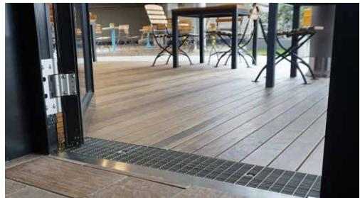
Vgradnja linijskega požiralnika **ACO Profiline** neposredno ob panoramska vrata omogoča izvedbo prehoda iz objekta na teraso z lesenimi podnicami brez arhitektonskih ovir.
