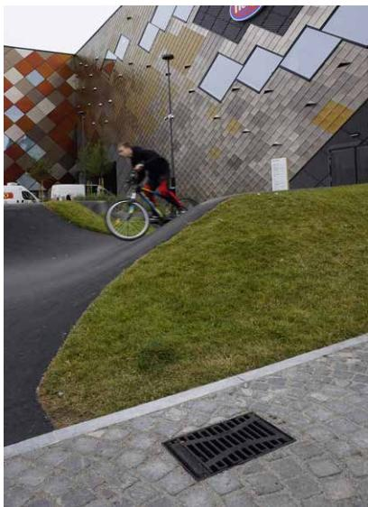
**Mostni požiralnik ACO HSD-2** v funkciji na parkirišču nad garažno hišo. Namenjen dvonivojskemu odvodnjavanju: odvodnjavanje površinskih vod in hkrati pronicajočih vod iz hidroizolacije na stropni plošči podzemne garažne hiše.
